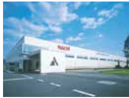
カーエアコン軸受工場
