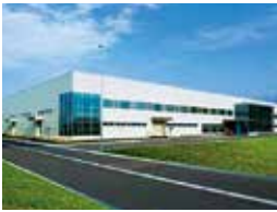
油圧モータ工場
