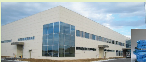
油圧モータ工場
