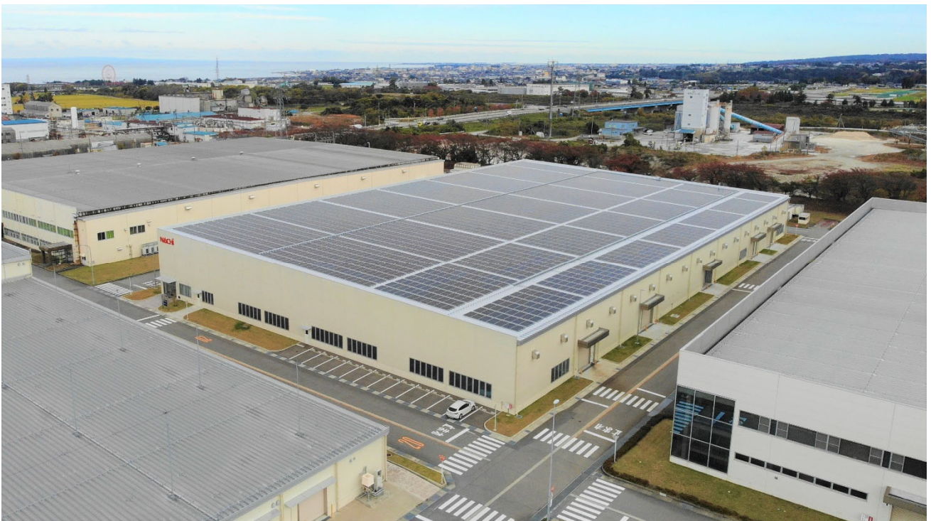
自家消費型太陽光発電システム(滑川事業所 油圧モータ第2工場)
